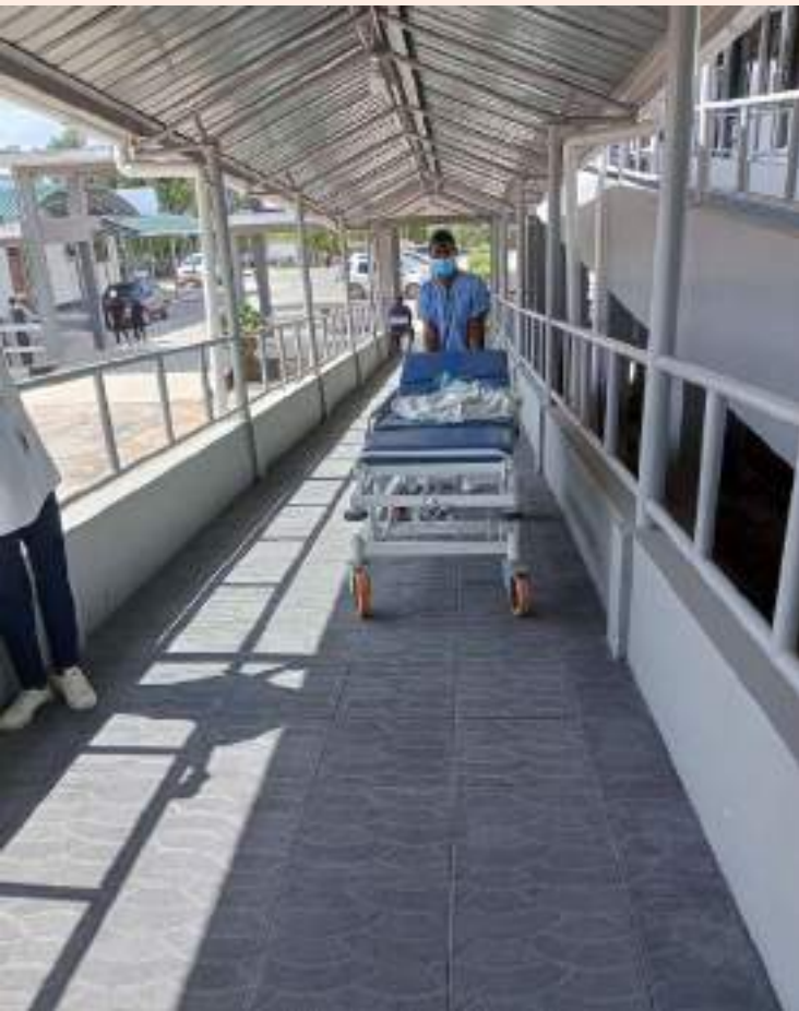
Ujenzi wa (Ramp) njia ya kupandisha wagonjwa kwenda wodi za ghorofani
